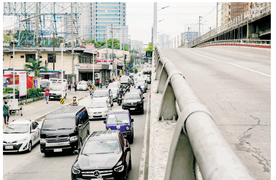
隨著EDSA-Kamuning立交橋關閉進行維修，交通開始堵塞。計順市EDSA南行車道的Kamuning立交橋旁的車流量週六開始增加。馬尼拉大都會發展局(MMDA)和公共工程和公路部(DPWH)最近宣佈完全關閉立交橋，以進行為期一個月的維修。
