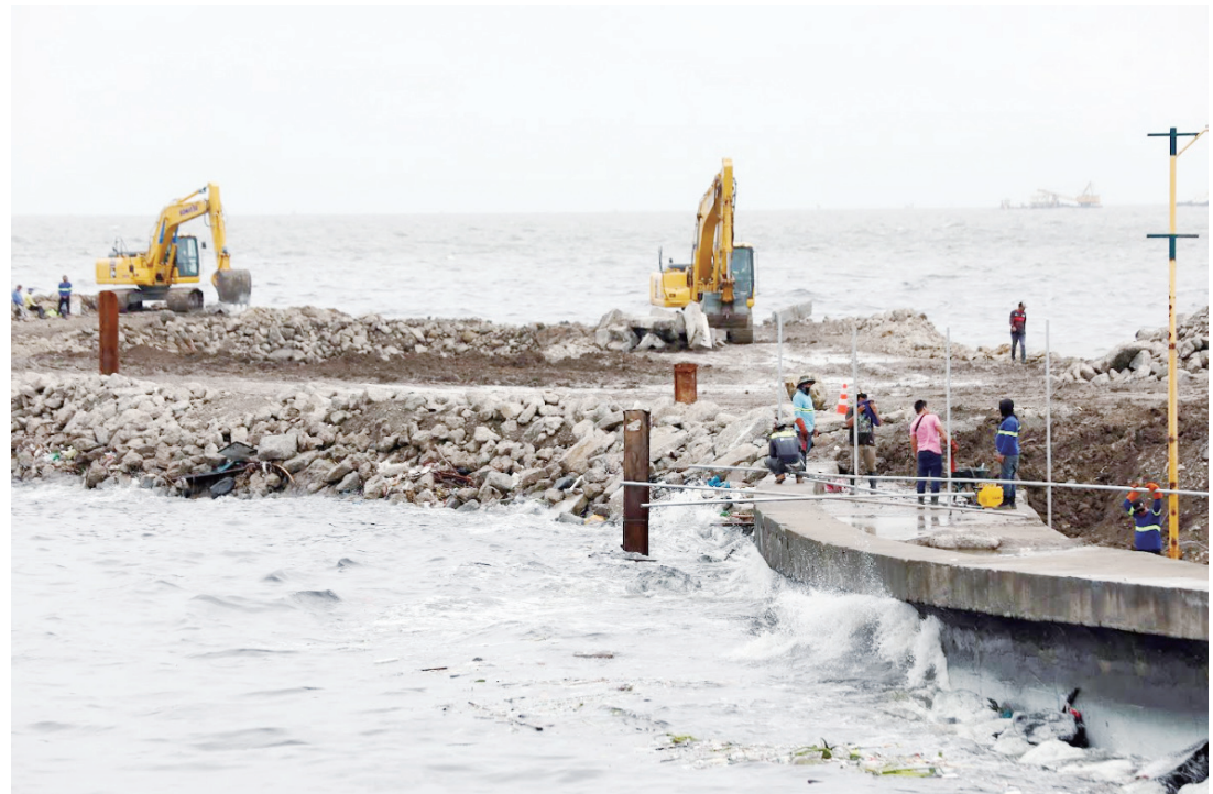
緊急維修。週五（2025年7月18日），公共工程和公路部（DPWH）的工人正在Navotas市對受損的河堤進行維護工作。該河堤於今年6月因漲潮帶來的水壓而倒塌，導致該地區洪水氾濫。
