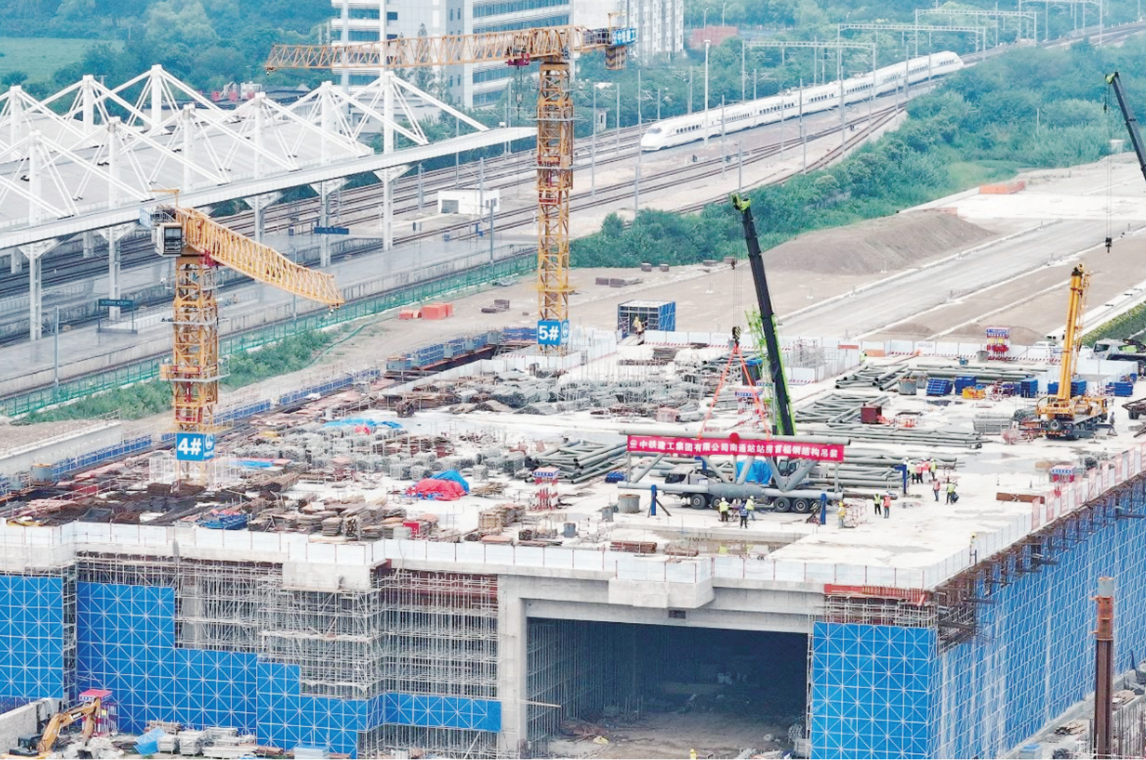
新建上海至南京至合肥高鐵南通站站房建設加速 鋼結構首節桁架吊裝完成 8月6日，新建上海至南京至合肥高速鐵路江蘇南通站站房鋼結構首節桁架吊裝完成，標誌著項目正式進入鋼結構安裝新階段。作為滬渝蓉高鐵的重要組成部分，新建南通站站房及相關工程由中鐵建工集團承建，站房建築面積約55000平方米，建成後站場總規模達3場9台20線，對助力區域內交通融合發展、推動長三角更高質量一體化發展等有重要意義。圖為新建南通站站房鋼結構首節桁架吊裝現場。 <中新社>
