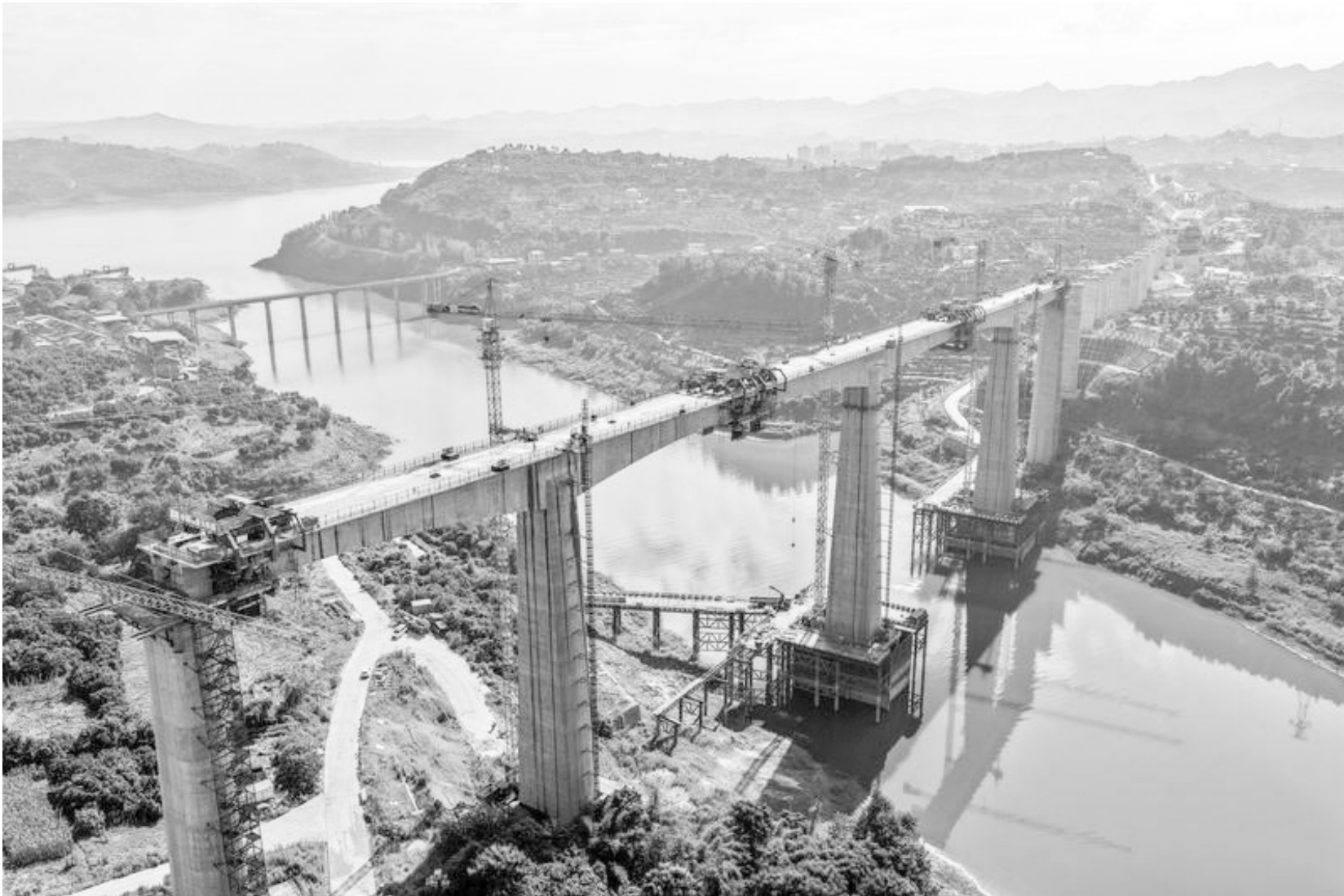
渝萬高鐵渠溪河雙線特大橋合龍 這是8月18日拍攝的渝萬高鐵渠溪河雙線特大橋施工現場。當日，由中國鐵建大橋局承建的重慶至萬州高速鐵路（渝萬高鐵）渠溪河雙線特大橋順利合龍。渝萬高鐵渠溪河雙線特大橋位於重慶市涪陵區珍溪鎮，全長約953米，是全線重難點工程。 <中新社>
