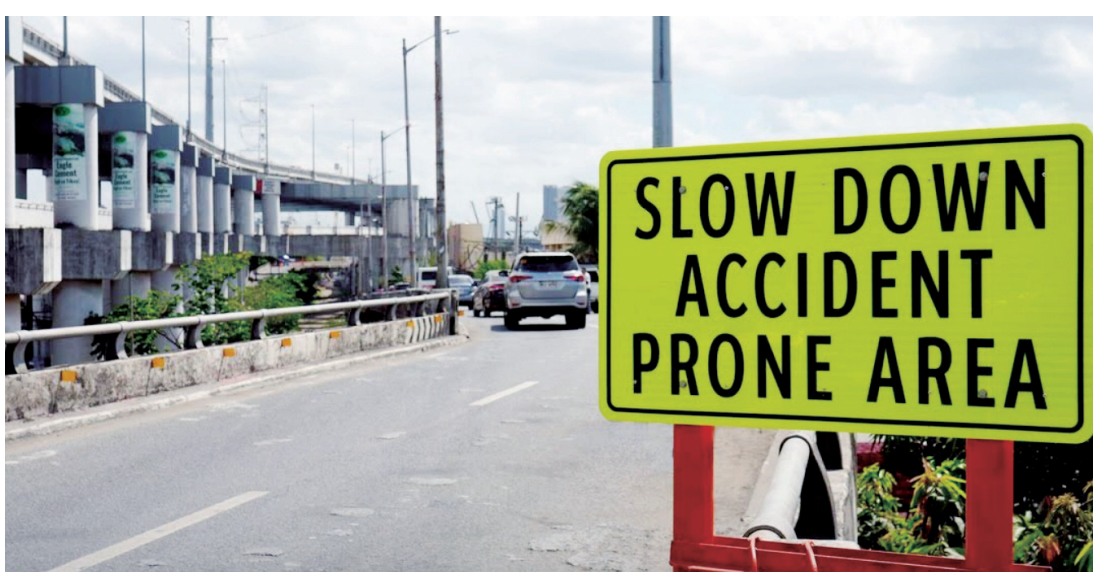
公造部（DPWH）週六開始對位於馬尼拉班納坎的Nagtahan連接高架橋（俗稱Beata橋）進行加固鋼製護欄和塗上反光漆，該橋事故頻繁發生。
