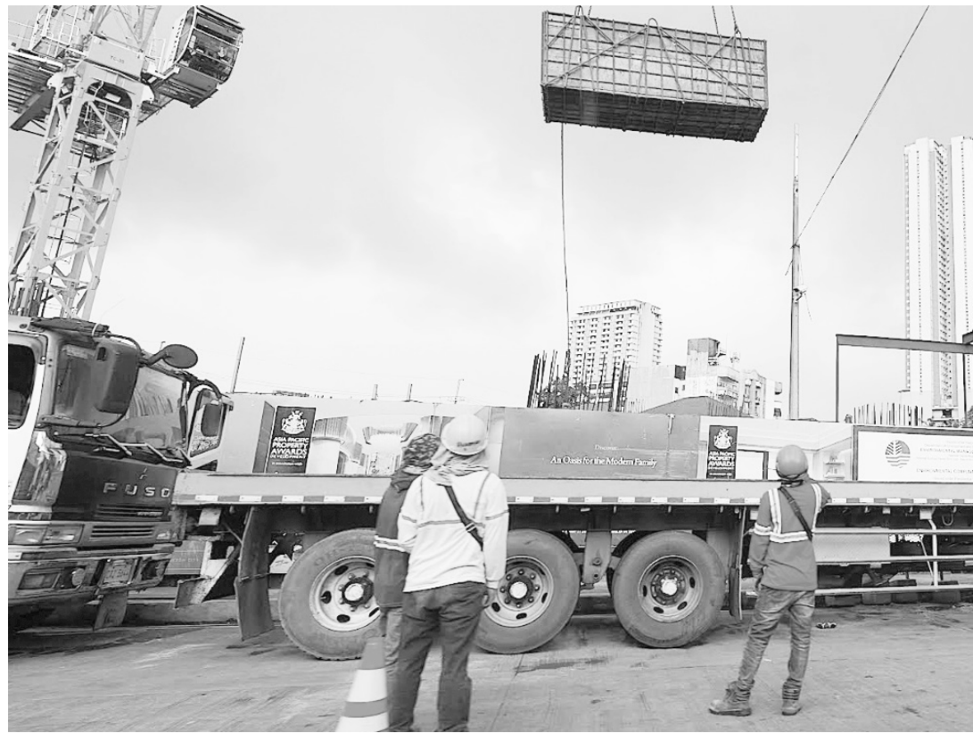
降雨預報。週六（2026年6月27日），在計順市第十一屆Jamboree街的一處工地，建築工人在陰沉的天空下搬運建築材料。東南季風持續帶來零星降雨和雷暴，但菲律賓責任區以外沒有活躍的熱帶氣旋。
