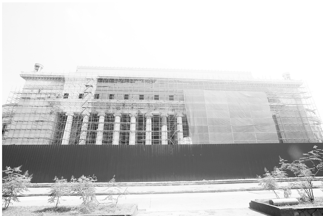
位於文尼法壽廣場的百年新古典主義建築——馬尼拉中央郵政局大樓，7月6日正在進行大規模結構加固和重新粉刷。耗資15億披索的修復工程第一階段專注於外牆柱子和主大廳。
