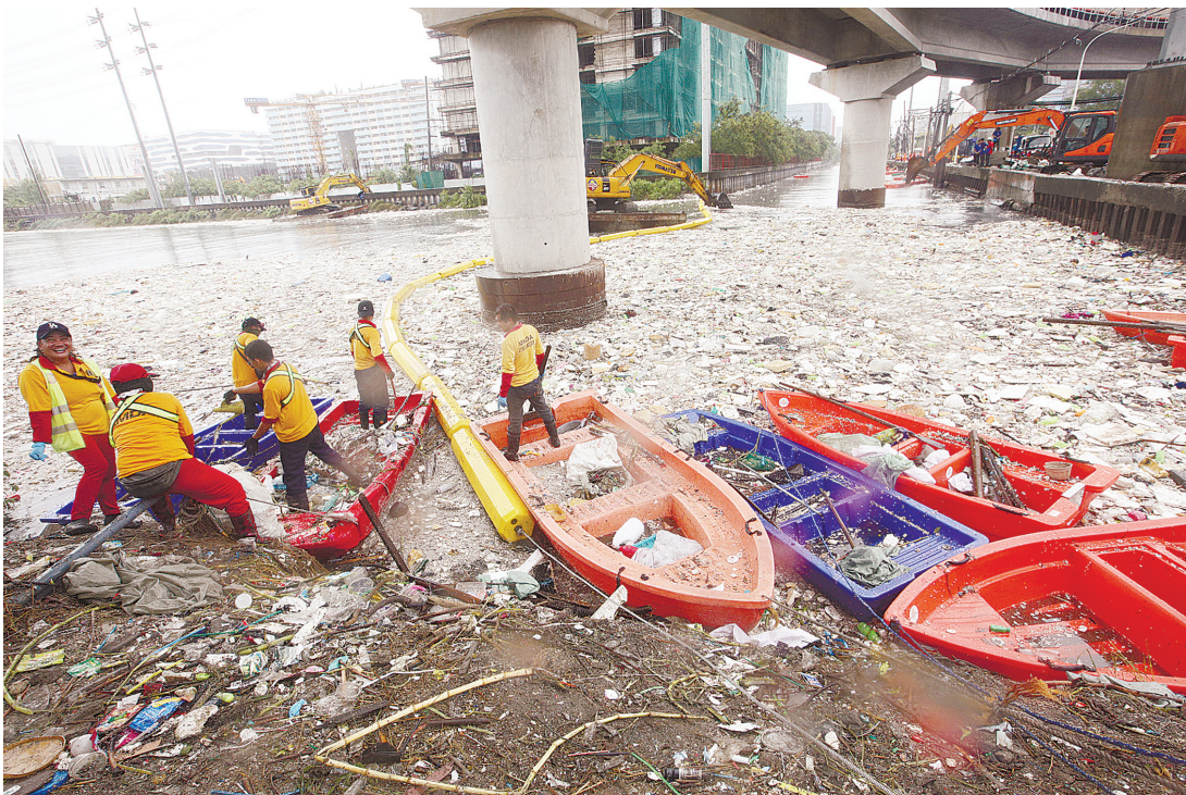
儘管連日強降雨，巴西市與巴蘭玉計市地方政府，連同大岷區發展署及公造部，於8月12日聯手清理巴蘭玉計市墨拉蘭村贖主會水道的成噸垃圾。為期兩天的清理作業共清除1921立方米的廢棄物與雜物，相當於約640公噸，動用117輛卡車運送。
