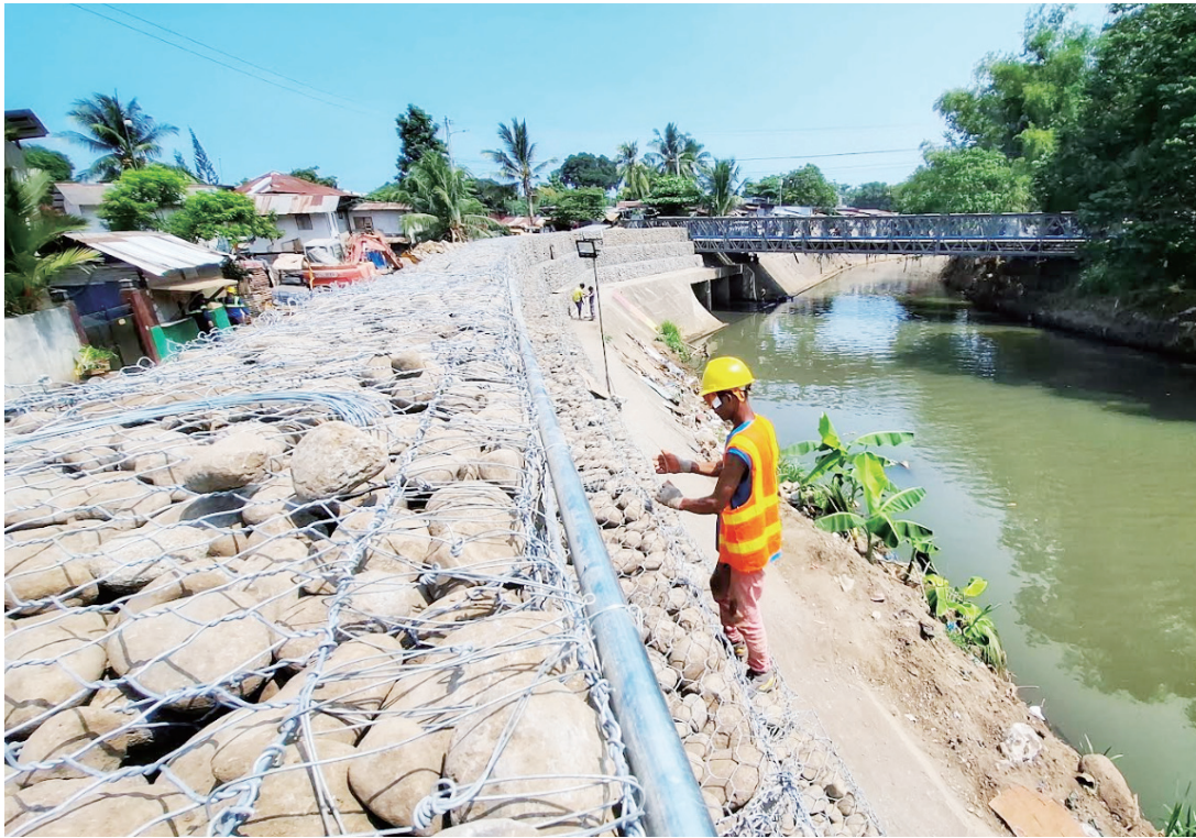
防洪工程。2026年9月4日（星期五），一名工人在納卯市達洛莫描籠涯塔阿爾1號仙范村安裝石籠。該防洪工程旨在加固河岸，以減輕暴雨對該市易澇地區的影響。
