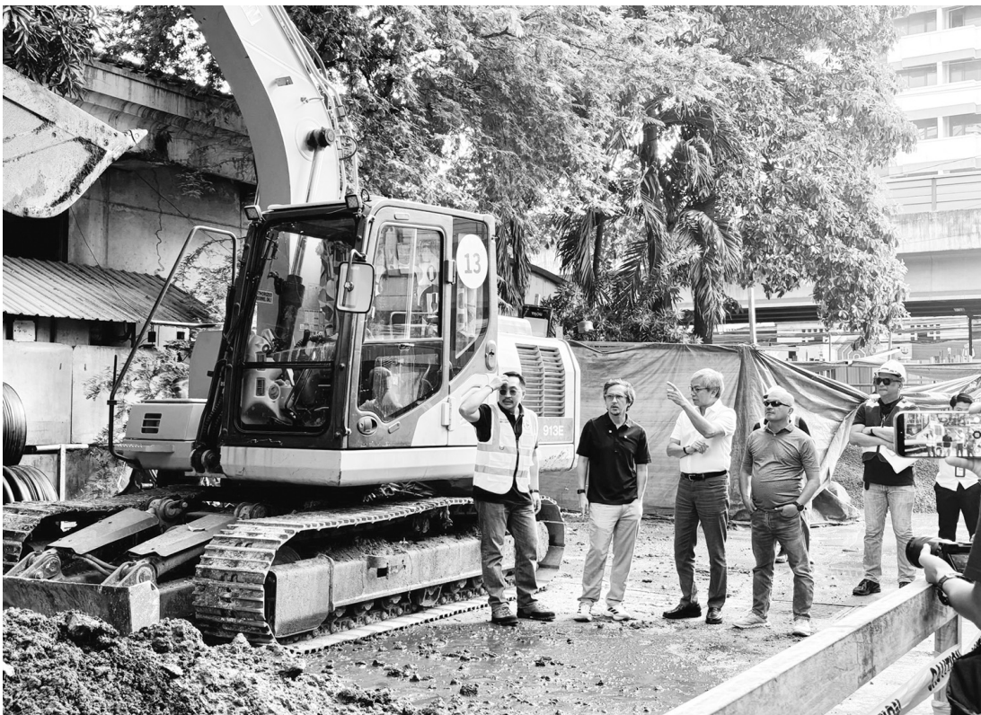
公造部部長文斯·迪順視察菲總醫院正在進行的修復和康復工程，該工程已延誤近兩年。
