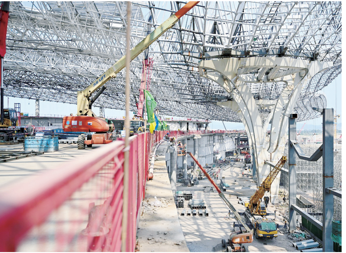
廣州白雲國際機場T3航站樓鋼網架結構屋蓋實現封頂 5月16日，廣東廣州，建設中的白雲國際機場三期擴建工程T3航站樓項目。近日，白雲國際機場三期擴建工程T3航站樓項目順利實現全面封頂，項目全面轉入金屬屋面及幕牆裝飾裝修施工階段。 <中新社>
