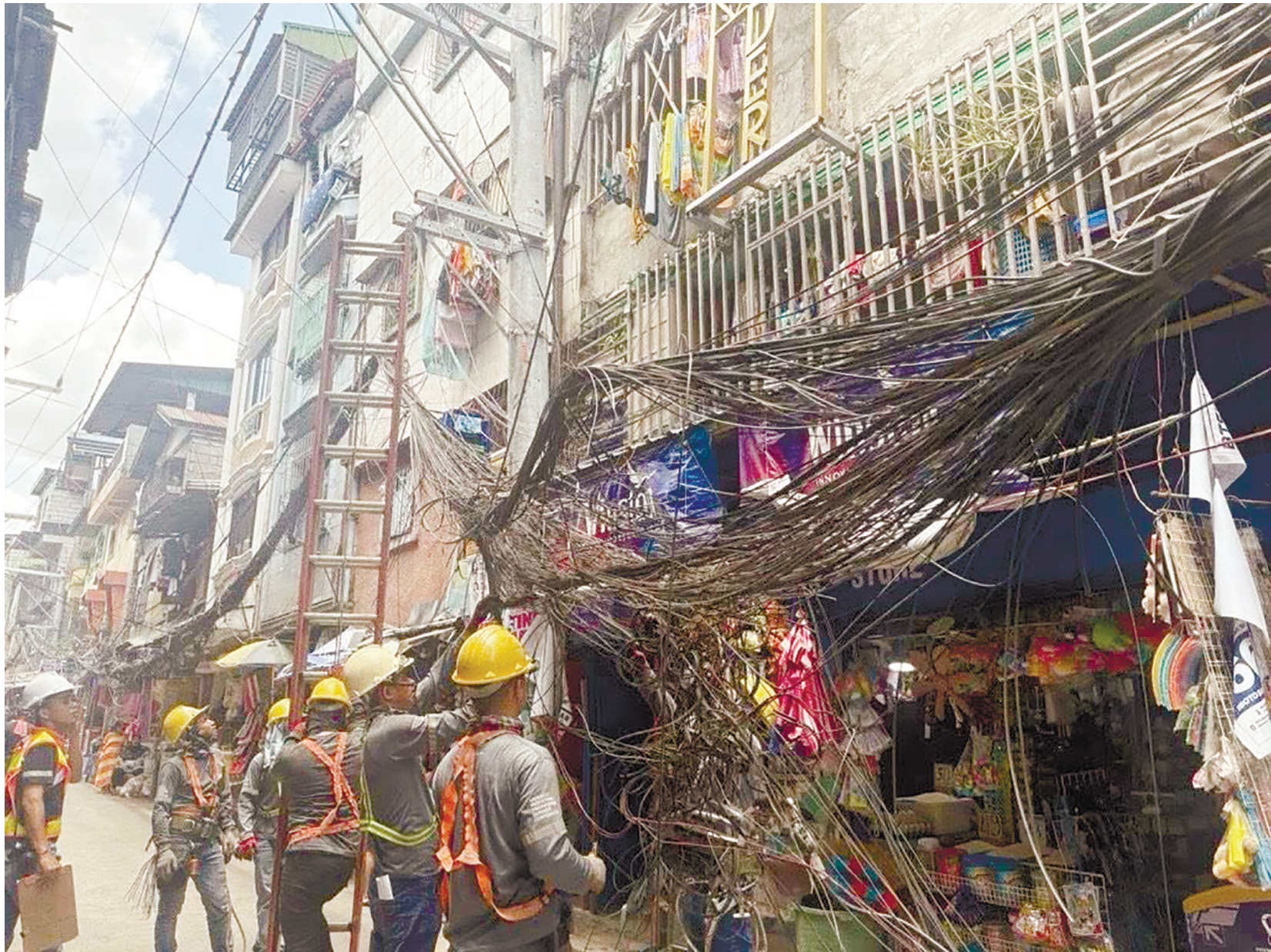
計順市庫利亞特社區薩拉姆園區正進行電線整頓作業，作為該市「懸垂電線清除行動」之一環。
