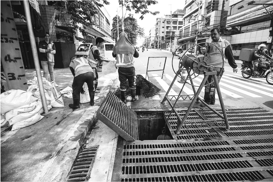
公造部持續進行排水系統清淤作業，圖為8月5日在計順市智穆大街的施工情形。作為國家首都區人口最多的城市，計順市也是7月西南季風及連串颱風引發洪災最嚴重的地區之一。
