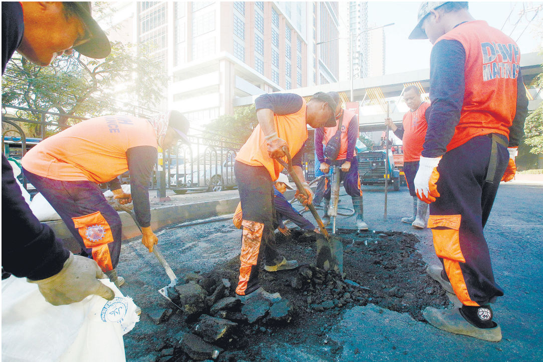
公造部工人2月19日在馬尼拉市伊西班牙迎大道填補坑洞。該部表示，此項持續進行之維護工作旨在提升道路安全、預防事故，並確保駕駛人與通勤民眾之行車平安。
