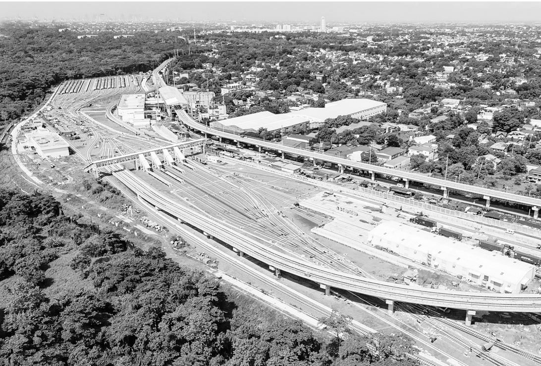
位於計順市拉格羅描龍涯基仁諾大街沿線的20公頃MRT-7機廠景色。在第五次國情咨文中，總統馬科斯承諾，從北大道至計順市聖心的MRT-7線12個車站將於2027年與南北通勤鐵路一同投入營運。
