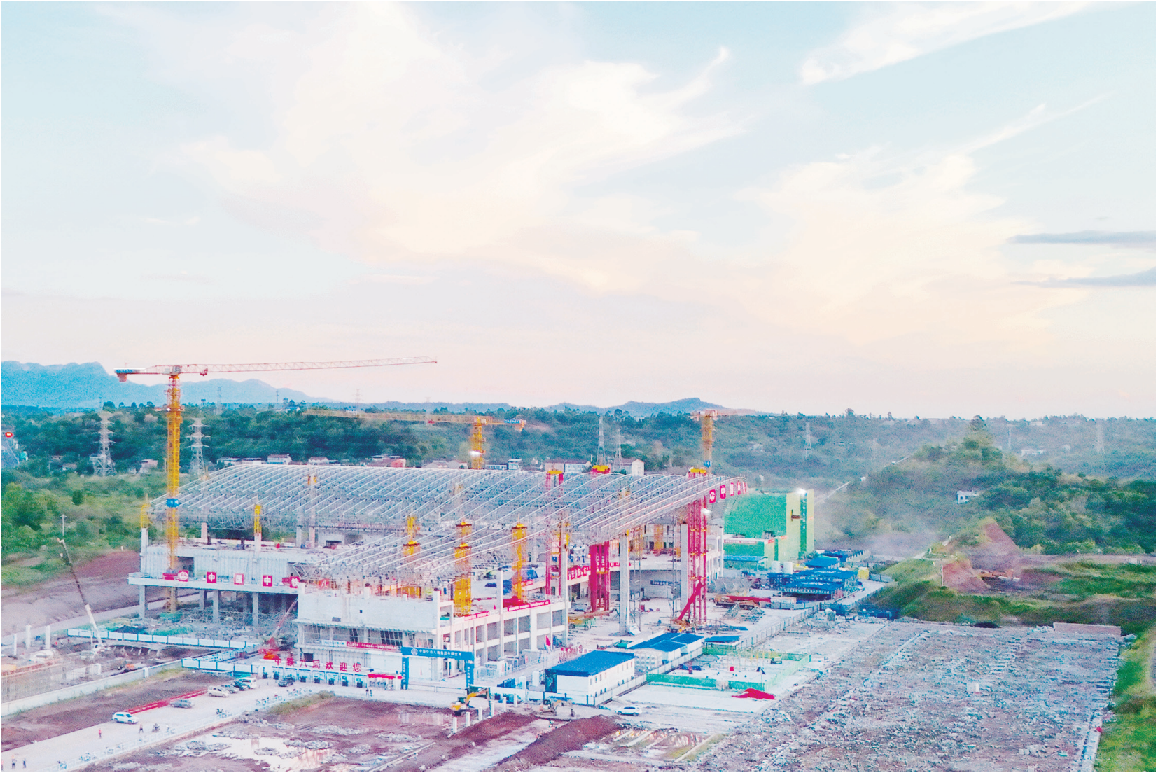
西渝高鐵廣安東站主體結構完工 8月6日，正在建設中的四川廣安東站。位于四川省廣安華鎣市明月鎮的西安至重慶高速鐵路（簡稱「西渝高鐵」）廣安東站主體結構完工，正式轉入裝飾裝修與設備安裝階段。西渝高鐵是中國「八縱八橫」高鐵網京昆通道和包（銀）海通道的重要組成部分。 <中新社>
