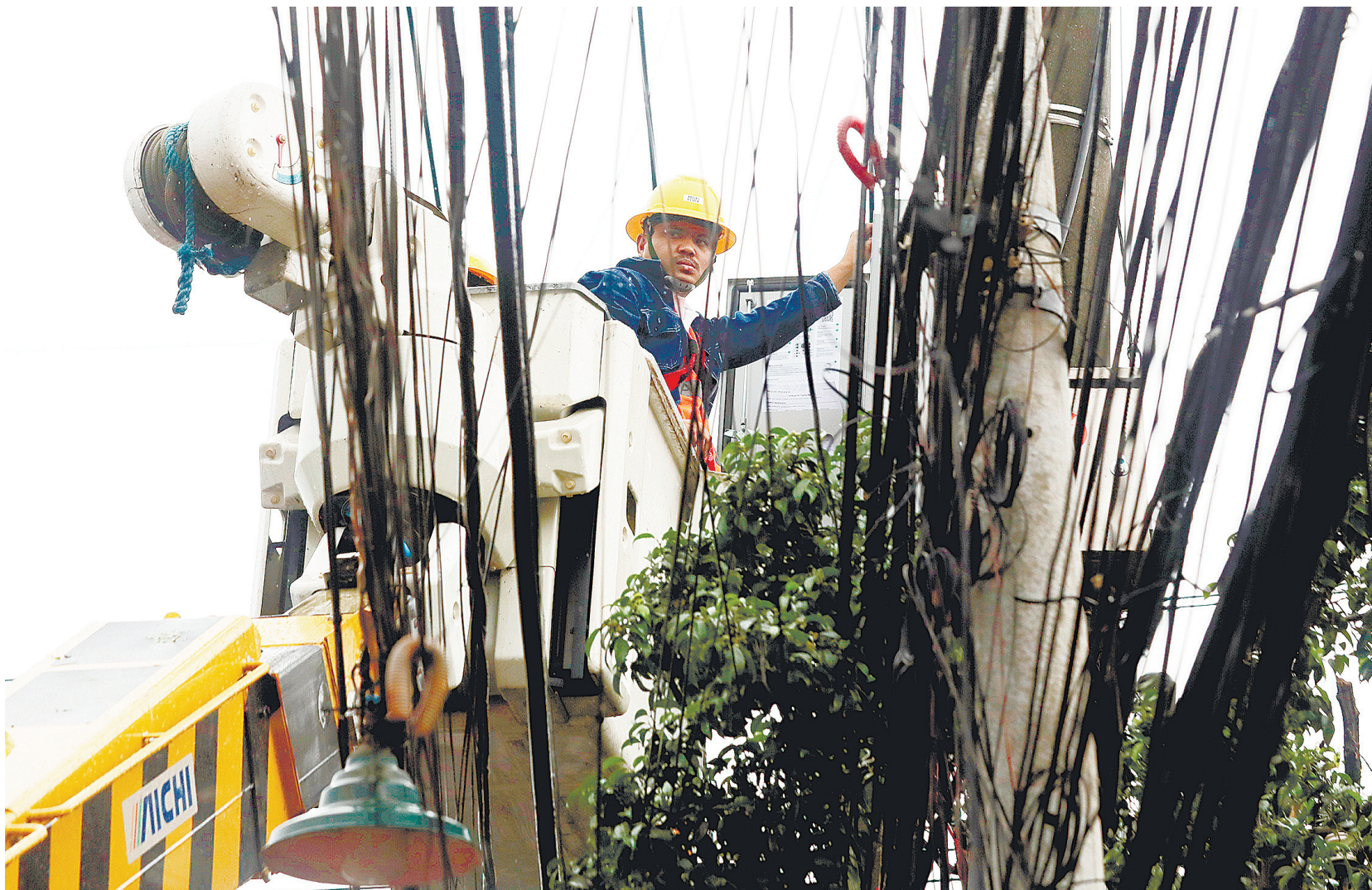
馬尼拉電力公司（岷電）的一名工人於8月13日（週四）在馬尼拉佛羅倫蒂諾延伸街沿線安裝配電盤。能源監管署已提出一項決議，建議取消目前對系統損失費用徵收的12%加值稅。
